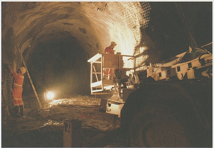
Sedrun – Sicherungsarbeiten in einem Querschlag.
