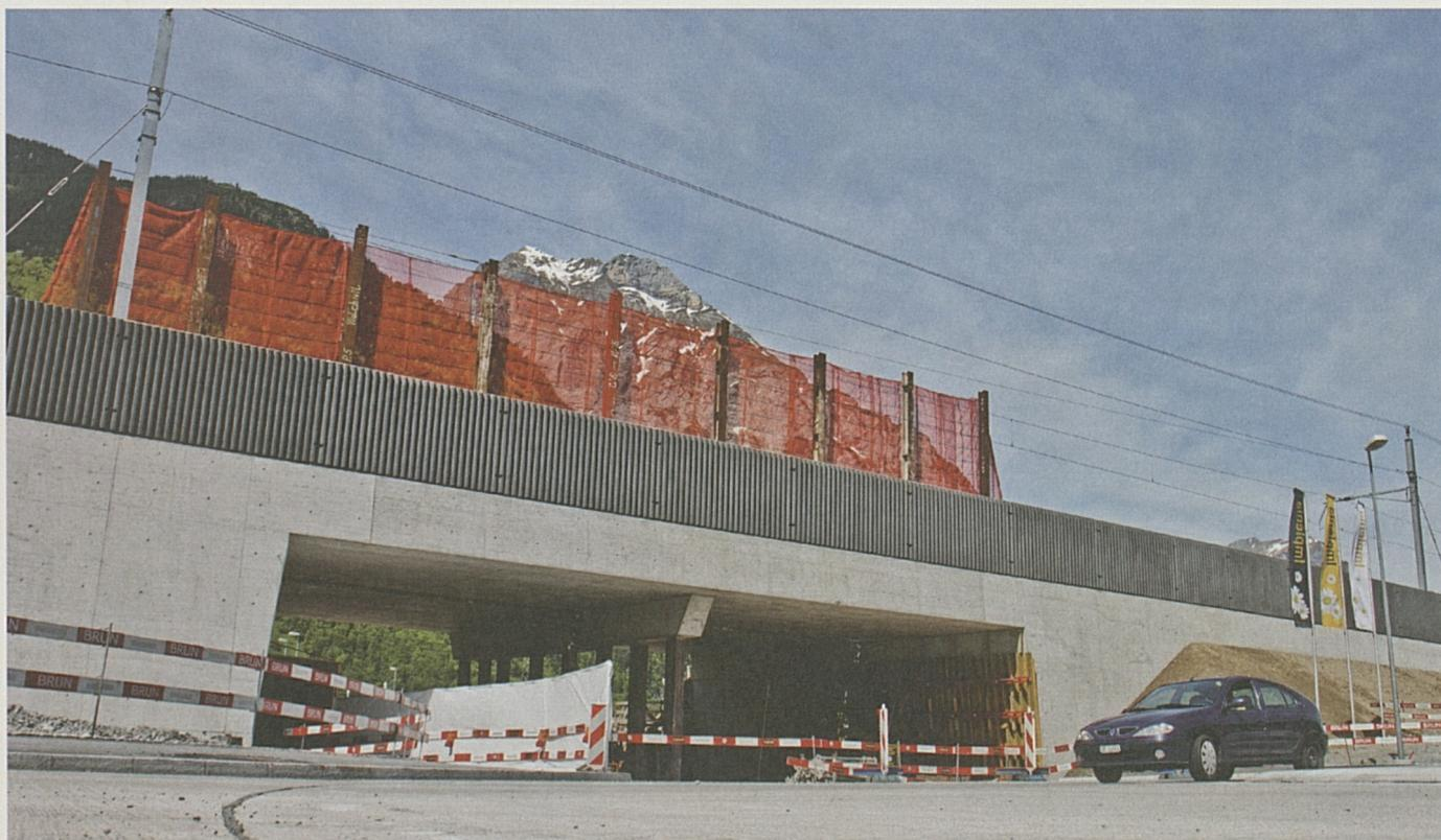
**Die Bauarbeiten an der Zufahrtsstrecke zum Gotthard-Basistunnel kommen zügig voran. Nachdem bei der Unterführung Wysshus Mitte April 2012 der «Durchschlag» erfolgte, kann die neue Verbindung bereits von Fussgängern und dem Langsamverkehr benutzt werden.**
