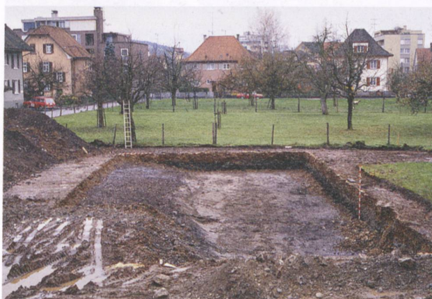
Abb. 5: Windisch-Wallweg 1979–1980 (V.79.6). Die Grabungsfläche mit grob geputztem, erstem Planum von Osten.
