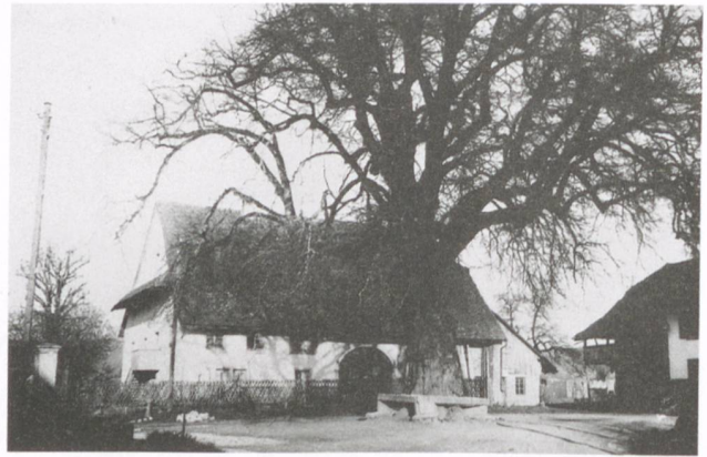
Abb. 11: Das «Haus Schatzmann» in Windisch-Oberburg, Ansicht von Westen vor dem Abbruch 1956/57: Ehemaliger Standort einer frühchristlichen Kirche?
