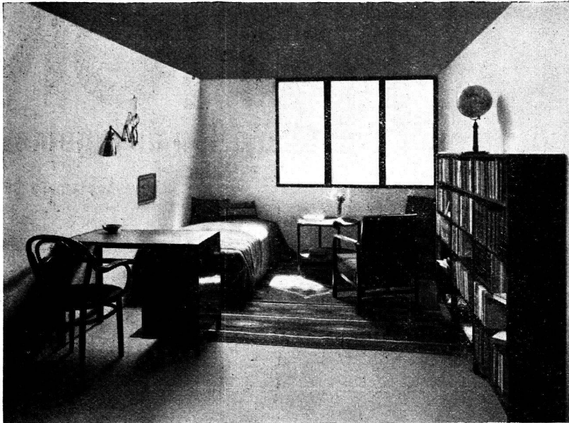
Artaria & Schmidt, architectes Bâle.
