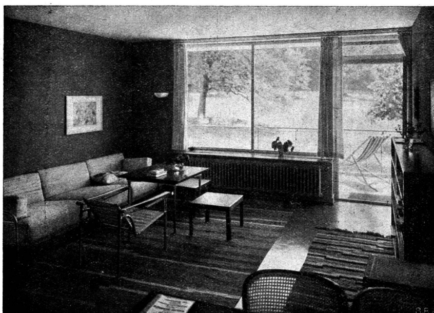
Chambre commune d'un appartement avec balcon.
