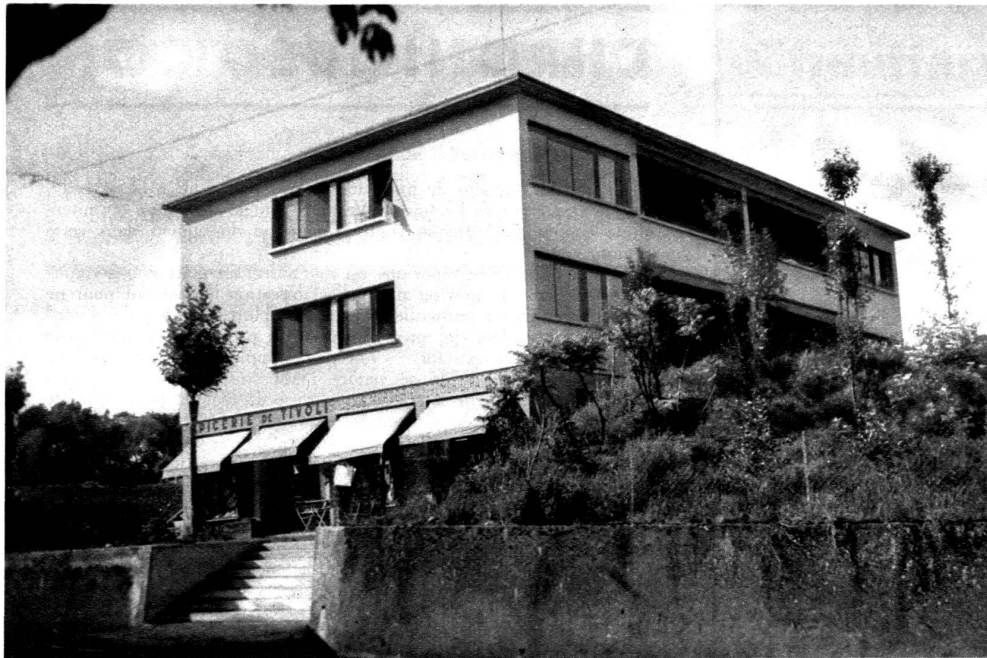
Vue de la face sur route de St-George avec terrasse et boutique.
