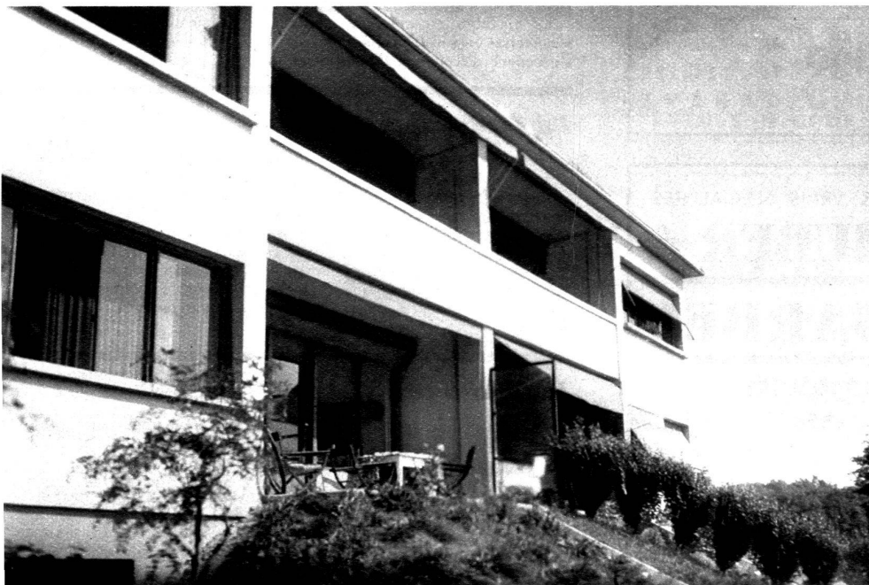
Les appartements du rez-de-chaussée sont pourvus de terrasses et ceux du premier étage de loggia.
