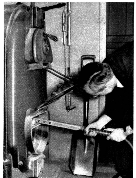
Allumeur à gaz pour chauffage central au coke.
