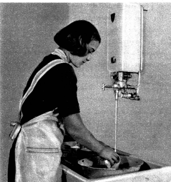
Petit chauffe-eau instantané, à gaz.
