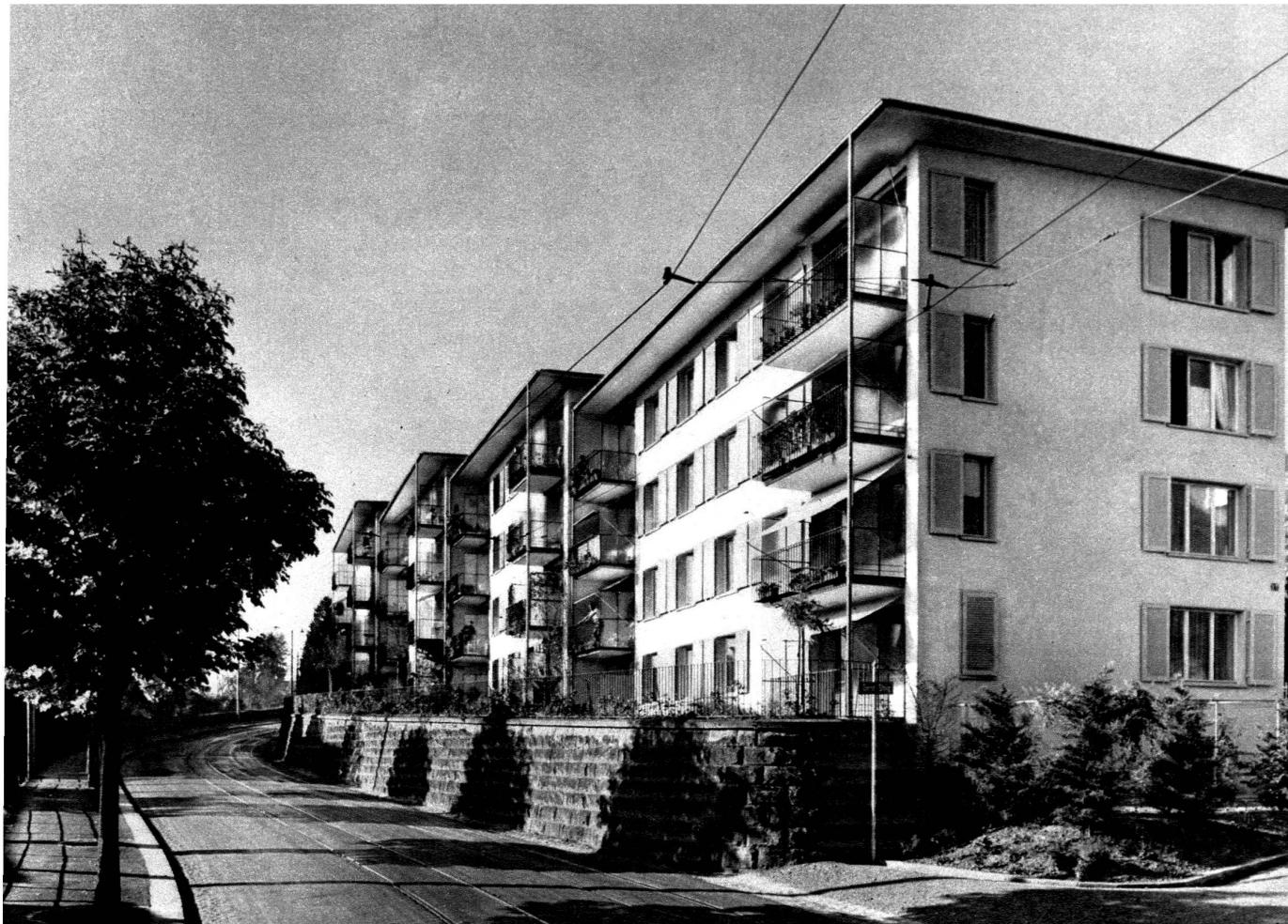
Groupe inférieur de quatre maisons sur la Hônggerstrasse.
