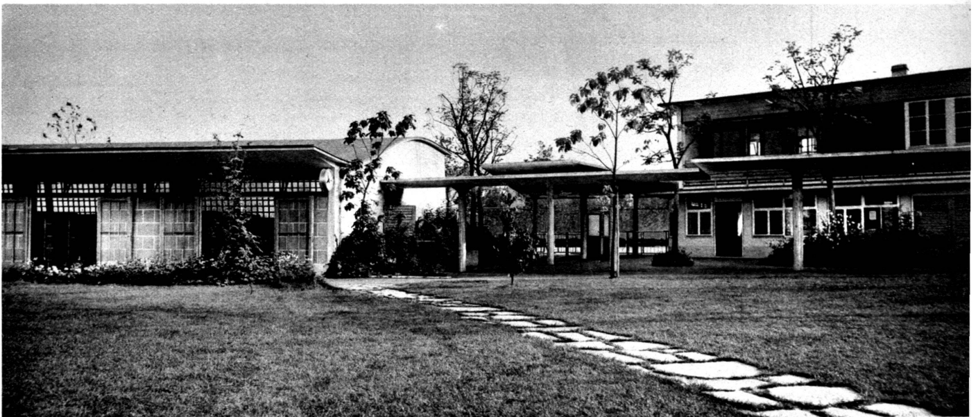
Entrée principale, vue de l'intérieur.
