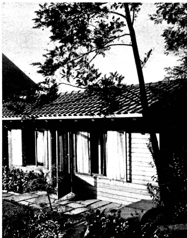
Vue de la face, côté terrasse.
