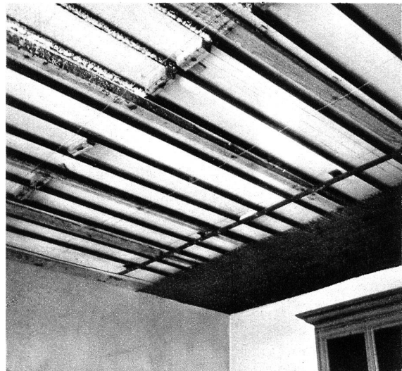
Installation de chauffage par le plafond en cours de montage.
