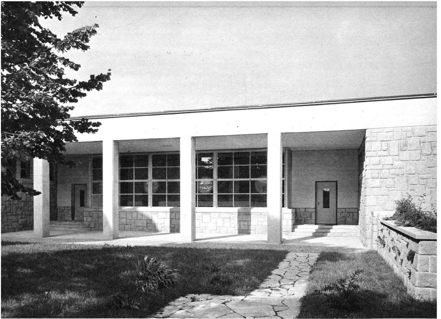
Portique de liaison entre les deux bâtiments.
