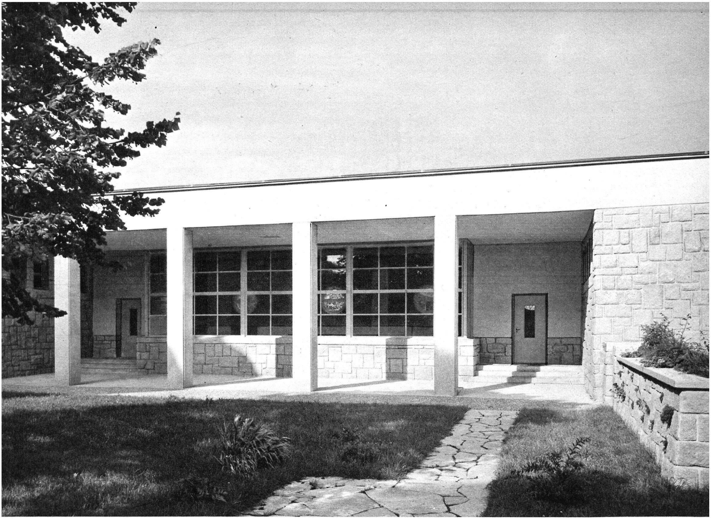
Portique de liaison entre les deux bâtiments.
