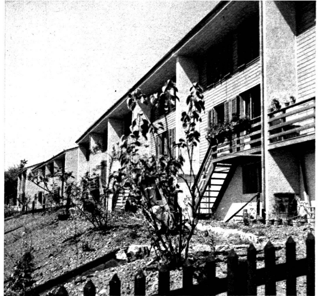
Détail de la façade sud du groupe II. On voit, sous la galerie, un des bras de l'étagère de linge amovible qui remplace l'étagère fixe si inesthétique dans la plupart des jardins de cités ouvrières.
