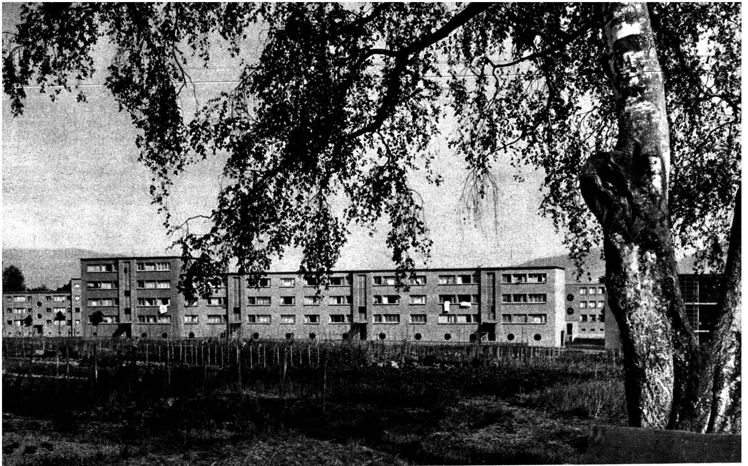
En haut : Un bâtiment du groupe D de la Cité-Vieusseux. Façade de l'entrée.
