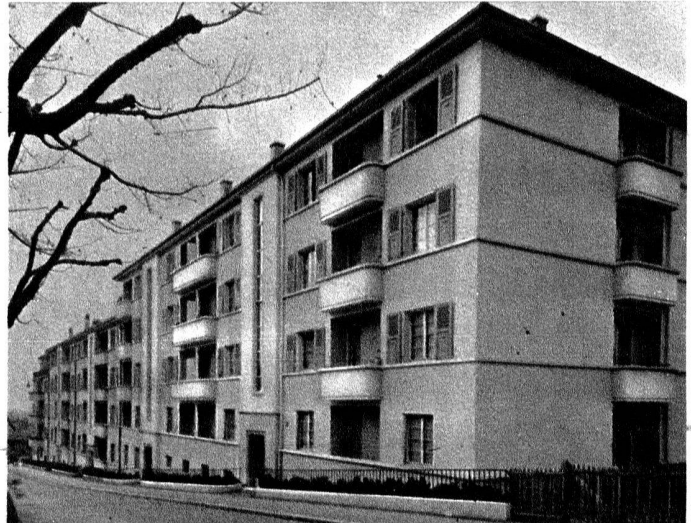
Façade sur le chemin de Fontenay.
