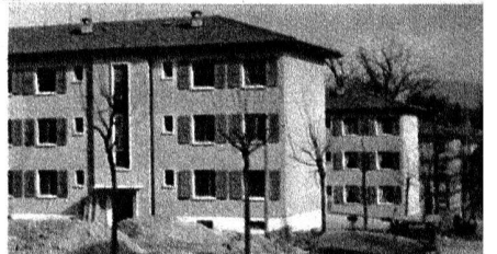
Façades des quatre rangées parallèles de la Cité Villard.
