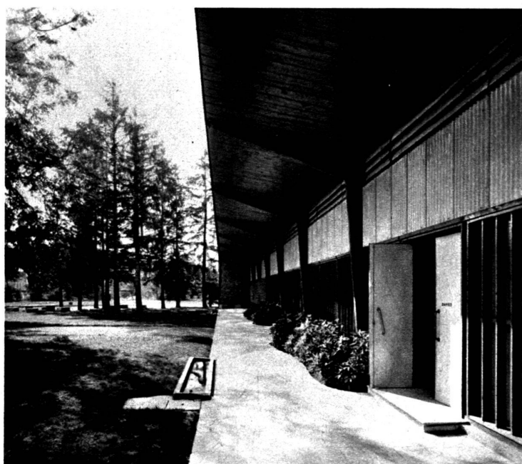
Le portique vu de l'est. Au premier plan, le pédiluve. (Photos Bosch.)
