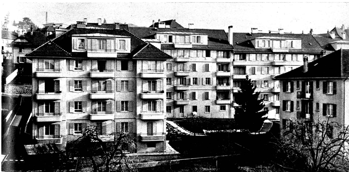
Groupe Marc-Dufour - Façades sud (Photo H. Chappuis, Pully-Nord).
