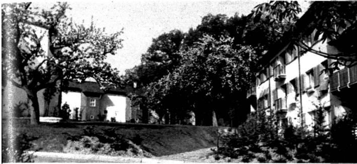
Les maisons du type A ont un escalier semi-extérieur.
