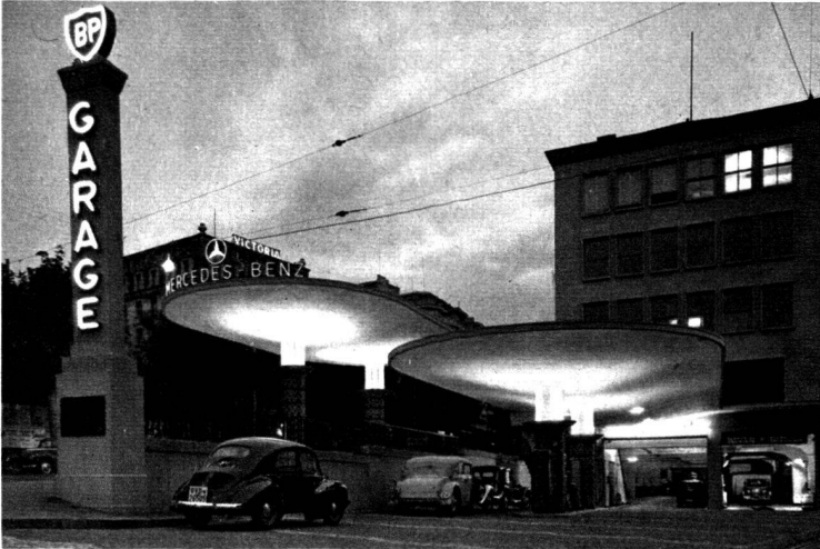
En haut à gauche : Les deux abris, devant le garage, sur la place et sur l'avenue de la Gare, avec leurs piliers en mosaïque.
