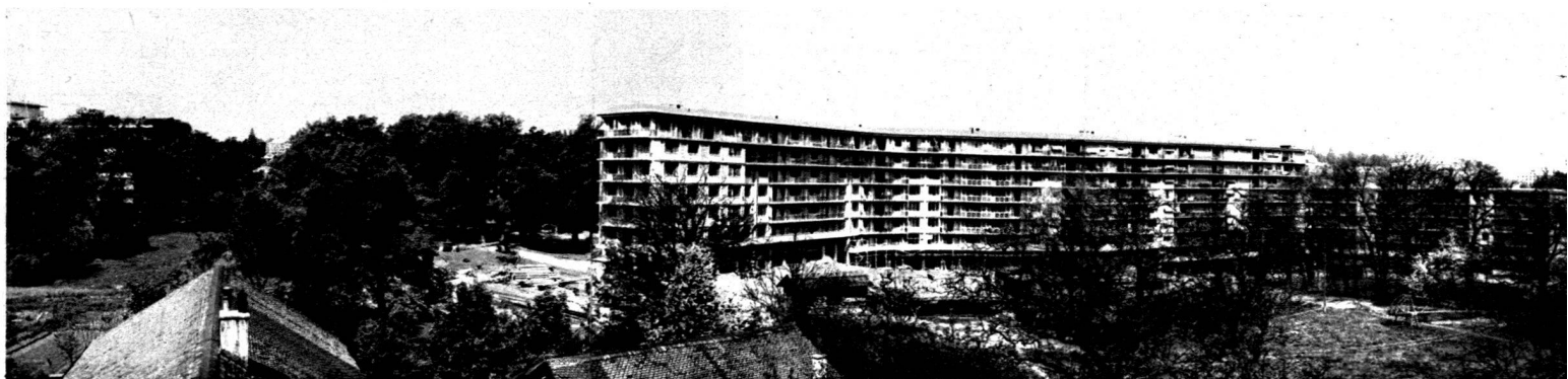
Vue générale du groupe en construction.
