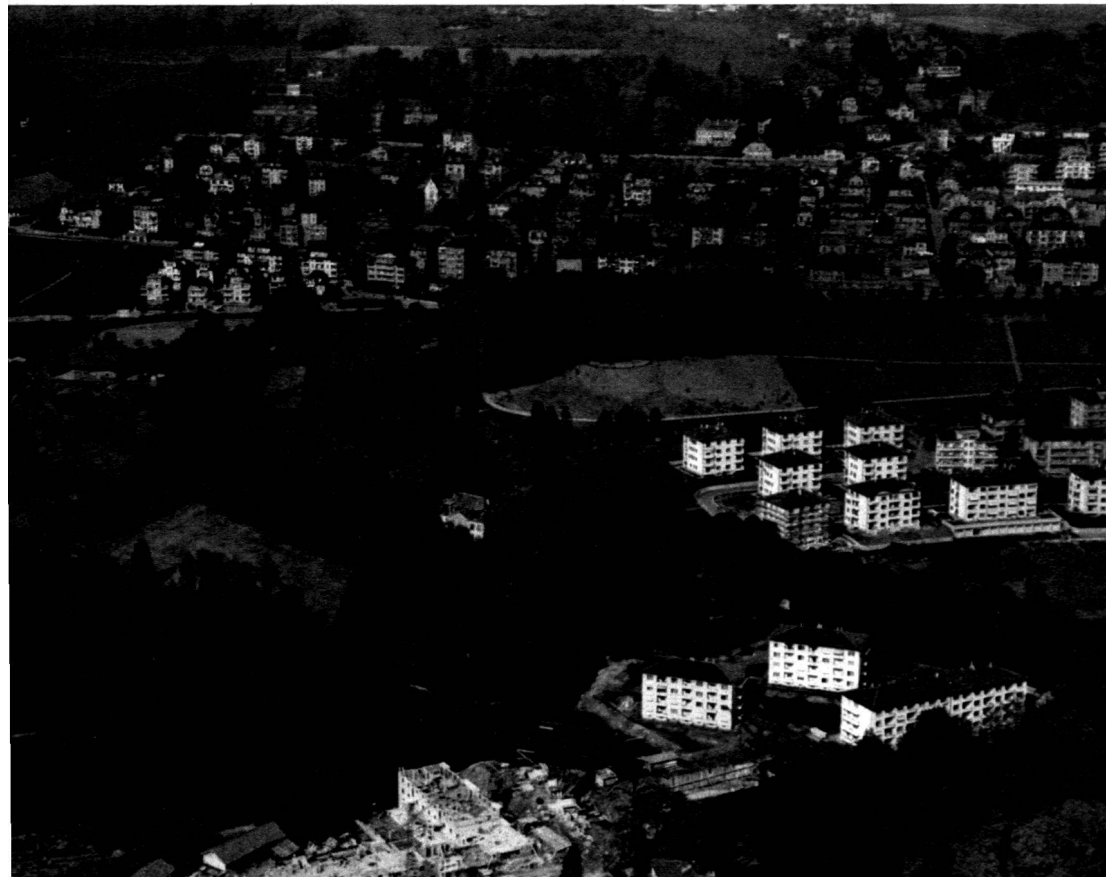
Le quartier du Château de Valency en construction. Photo Wurgler.
