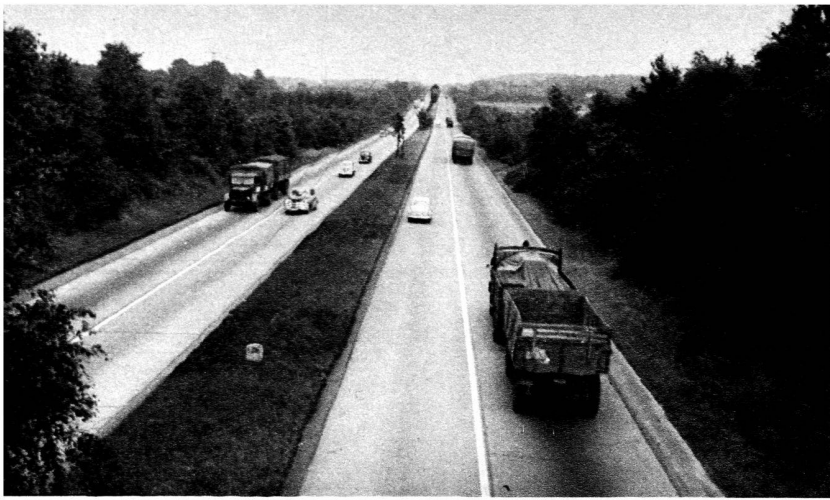
◀ L'autoroute Cologne—Dusseldorf, bassin de la Ruhr. L'une des plus fréquentées des autoroutes allemandes ; est surtout utilisée par les poids lourds. De construction déjà ancienne, elle ne possède pas d'accotement stabilisé pour le stationnement. (Photo B.P.A., Berne.)
