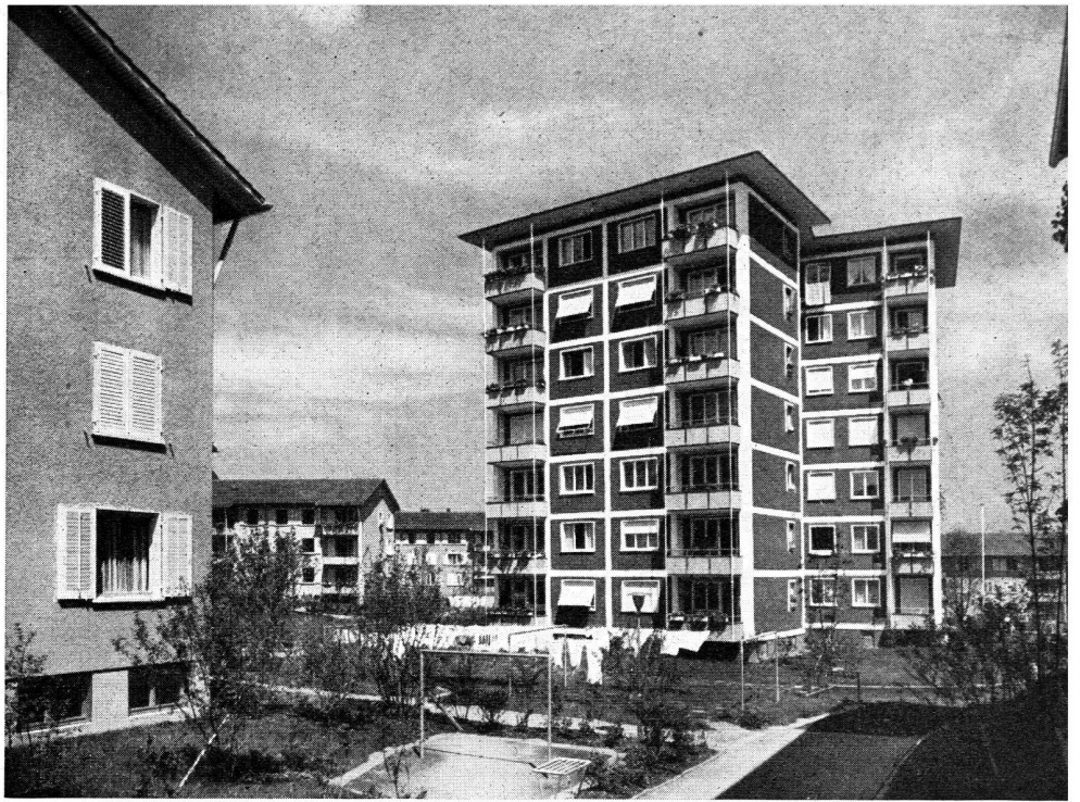
Cité d'habitations « Im-Moos », Zurich. Maître de l'ouvrage: « Allgemeine Baugenossenschaft Zürich, A. B. Z. » Eschlimann & Baumgartner, architectes. Cette cité comprend vingt-neuf maisons de différents types, dont cette « maison-tour », deux cent un logements, deux magasins de vente, deux jardins d'enfants, neuf garages. Vue de la maison-tour au sud. (Cliché Das Wohnen.)
