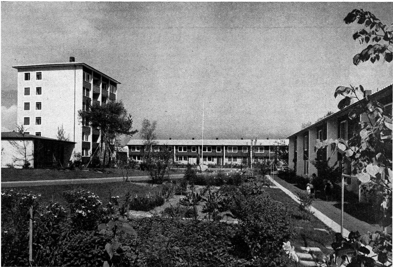
Cité-jardin « In der Au », à Zurich, pour familles nombreuses à revenus modestes. Le centre de la cité; à gauche, le pavillon scolaire et l'immeuble de six étages. Maître de l'ouvrage: « Stiftung Wohnungsfürsorge für kinderreiche Familien der Stadt Zürich. » Cramer, Jaray, Paillard, Baerlocher, Unger, architectes. (Cliché Das Werke, photo Wetter, Zurich.)
