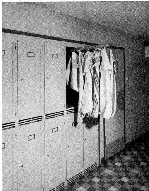
36. SÉCHOIRS A LINGES DANS ARMOIRES CHAUFFANTES (GYMNASTIQUE)
