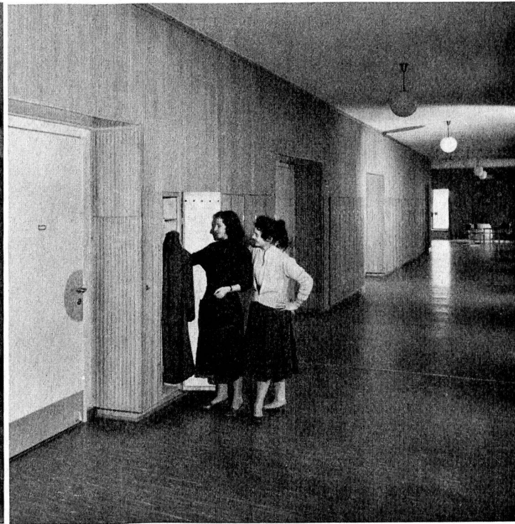
37. ARMOIRE-VESTIAIRE ENCASTRÉE DANS LA PAROI.
