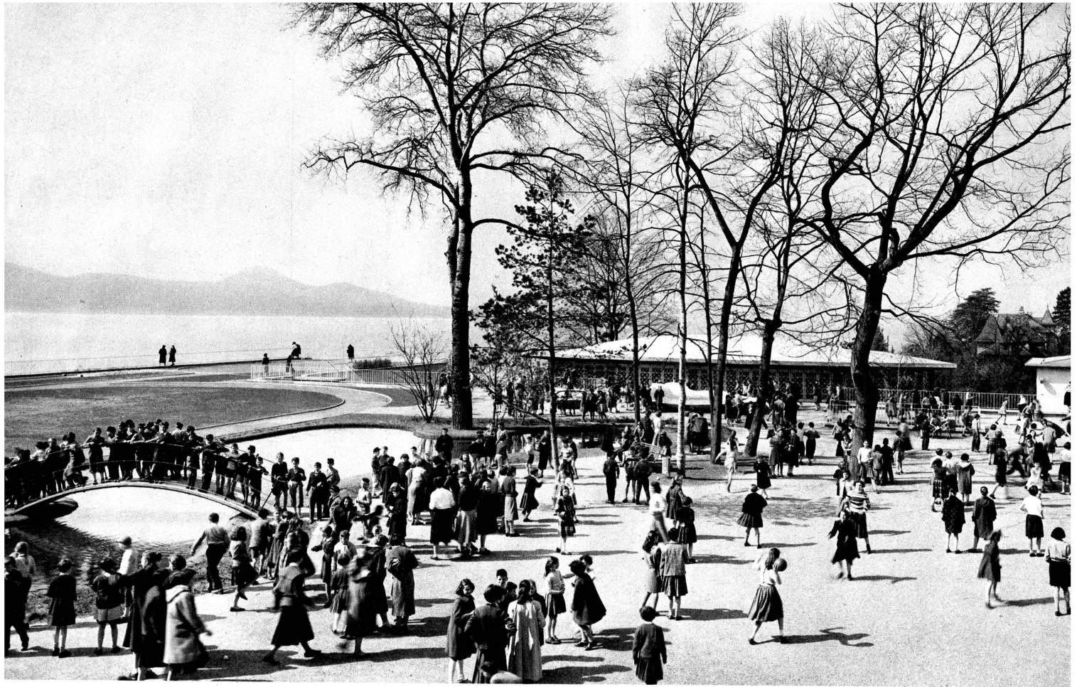
4. PRÉAU DU COLLÈGE. CI-DESSOUS: 5. HALL DU COLLÈGE.
