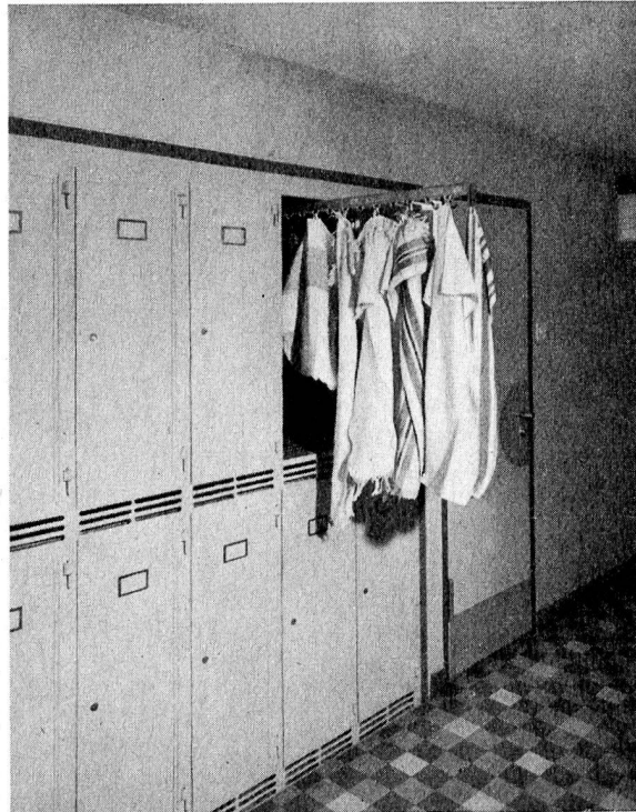
36. SÉCHOIRS A LINGES DANS ARMOIRES CHAUFFANTES (GYMNASTIQUE)
