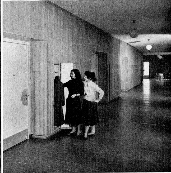
37. ARMOIRE-VESTIAIRE ENCASTRÉE DANS LA PAROI.
