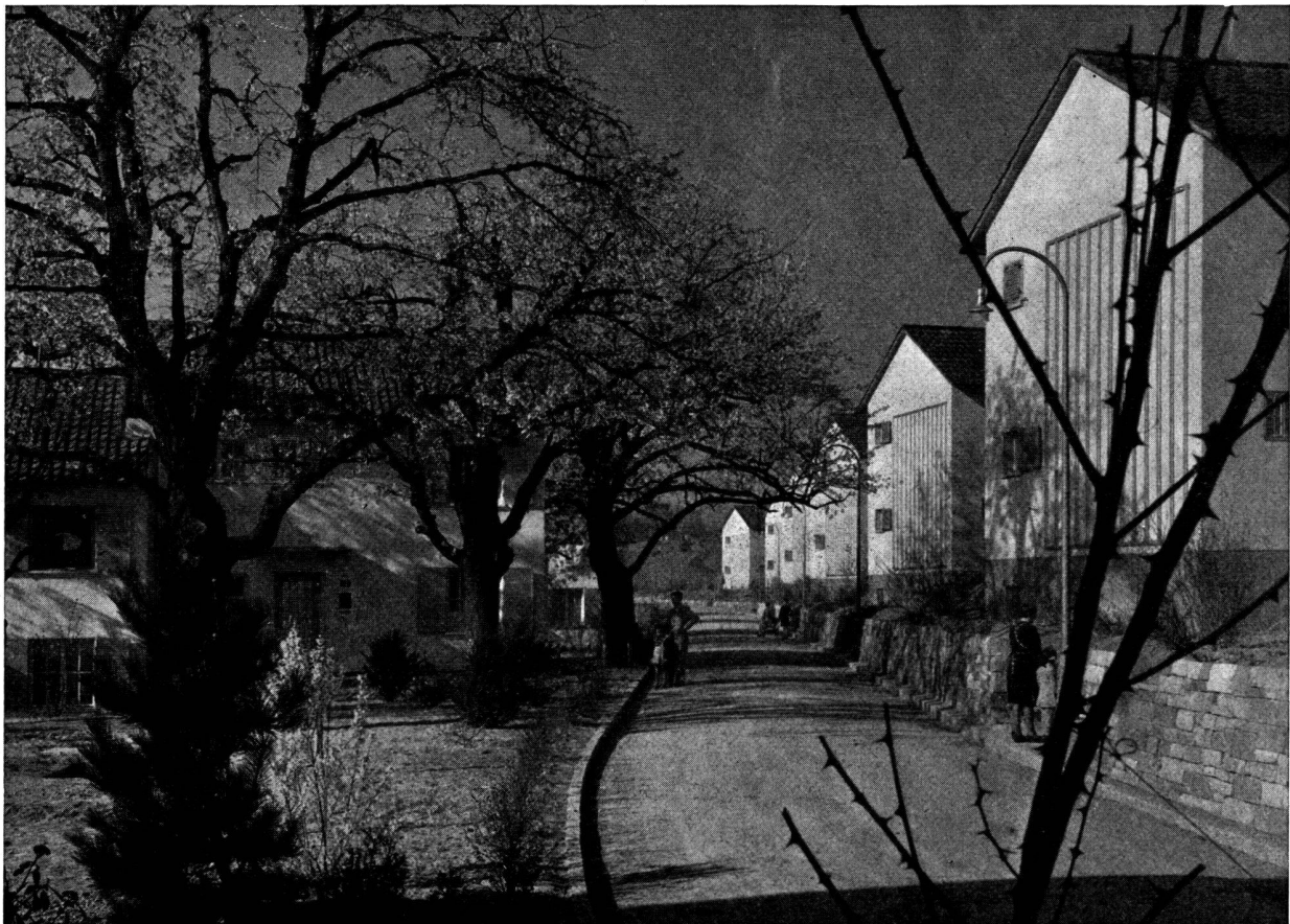
Une rue de la cité Jakobsberg. A gauche, type D, à droite, type C. (Cliché Das Werk.)
