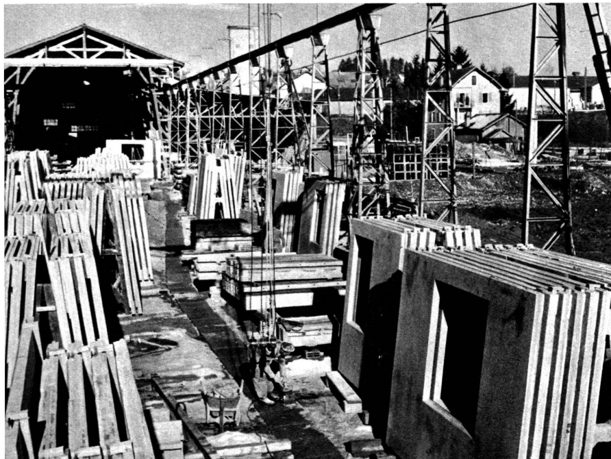
1 Les immeubles achevés. 2 Entreposage des éléments en usine. 3 Etapes successives du chantier; à droite: montage d'un élément.
