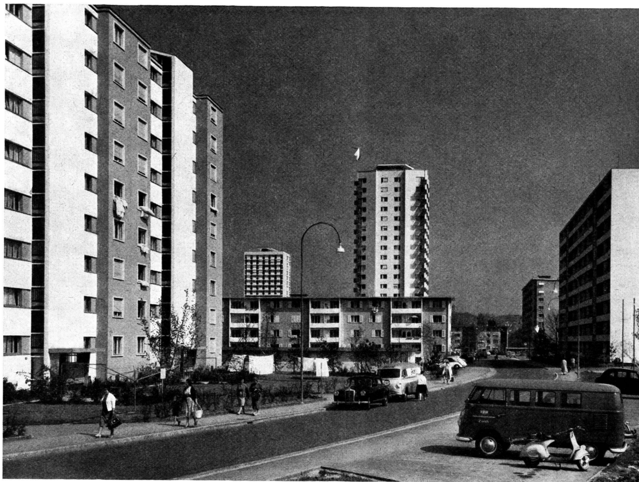
4 La nouvelle route d'accès au quartier Hirzenbach — La tour de l'arrière-plan a pour auteur R. Castelnuovo (Les clichés de ces trois pages nous ont été obligeamment prêtés par «Werk»)
