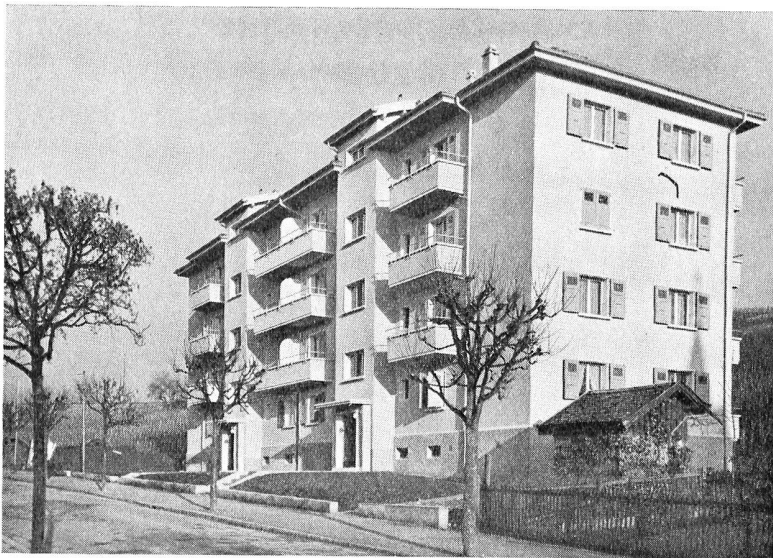
Ci-contre à gauche: Bâtiment «B» En bas à gauche: Bâtiments «E» et «F» Page 27: Bâtiment «D»
