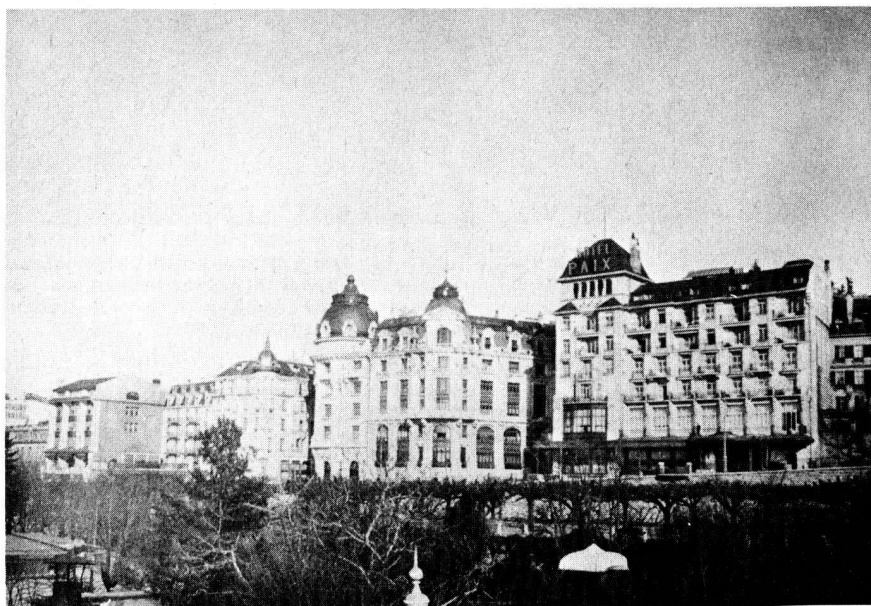
Fig. 50. Derrière-Bourg après les transformations de 1910-1915. Au premier plan, Hôtel de la Paix et Crédit Suisse.
