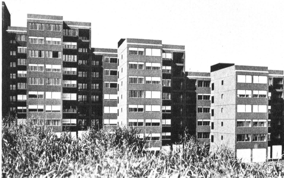
Vue partielle de l'un des immeubles, qui montre les décrochements non seulement en hauteur, mais aussi en façade.
