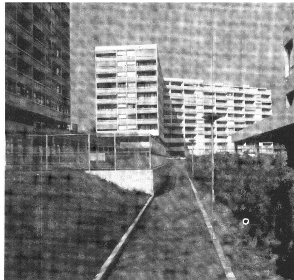
Le nouveau Vieusseux: à gauche, une partie des immeubles «B»; au fond, le groupe d'immeubles «C» remplaçant les petits immeubles démolis.
