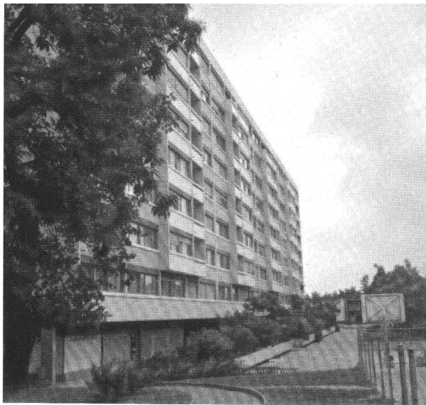
Le premier nouvel immeuble de la Cité Vieusseux: groupe «A».
