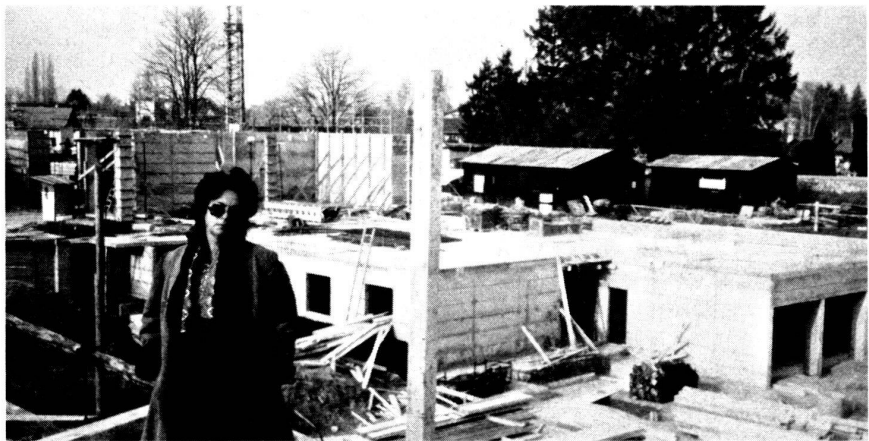
Le chantier dans son état actuel, au premier plan Mme Agent, fondatrice et directrice de la résidence.
