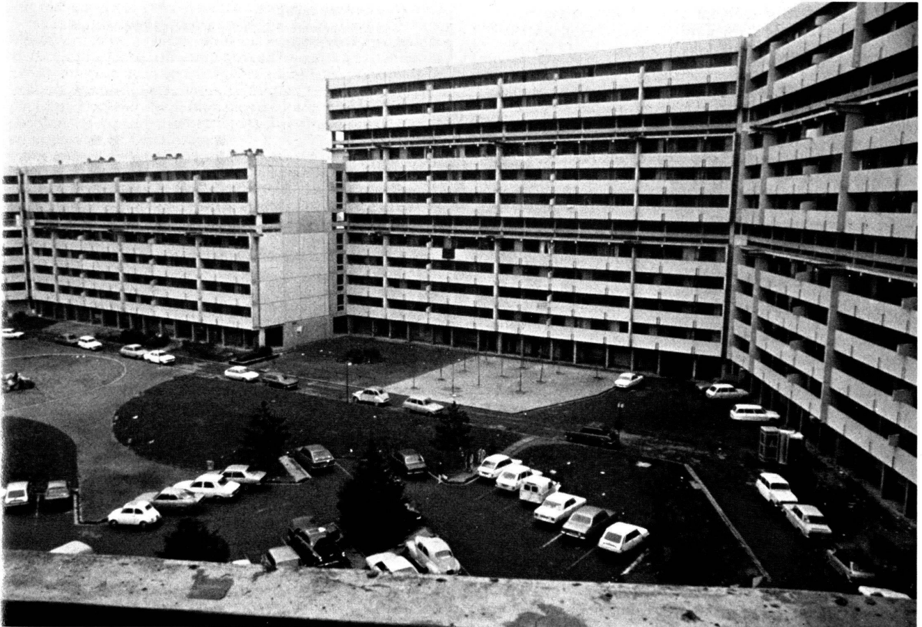
Toulouse-Le-Mirail : un des premiers bâtiments réalisés ; tous les 4 étages on trouve une coursive extérieure qui permet de parcourir toute la longueur de la construction.
