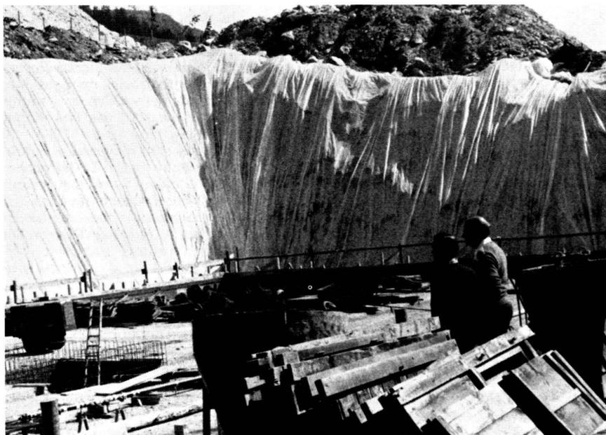
primée. Monarflex est étendu directement sur le sol. Il n'y a plus d'espace entre la bâche et la terre (important en cas de vent ou de tempête). La fixation est réalisée rapidement et de façon aisée au moyen de piquets de sol qui sont placés dans les œillets de fixation disposés judicieusement dans la bâche. Le principe est analogue à celui du montage d'une tente.
