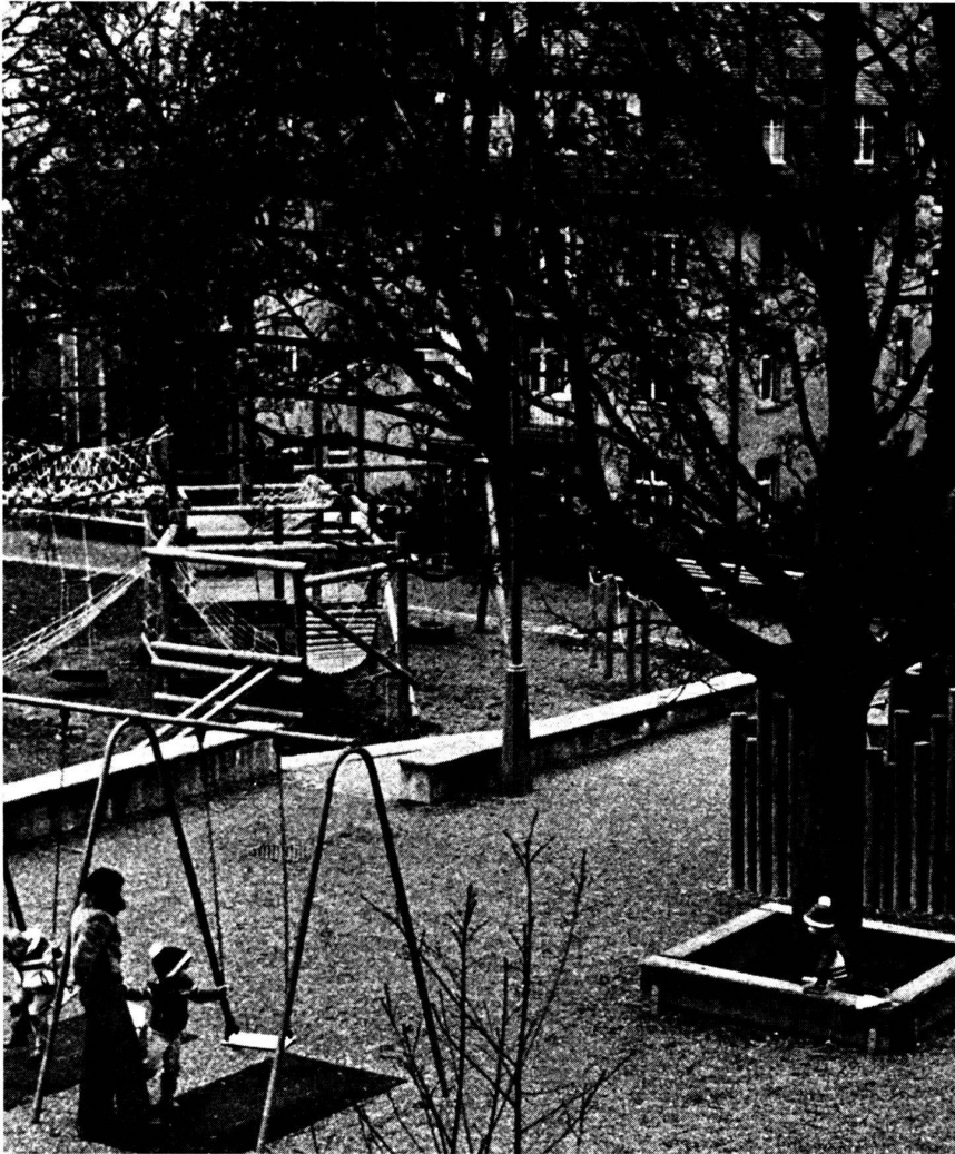
Aménagement d'une cour à Zurich, près de la Rigiplatz.
