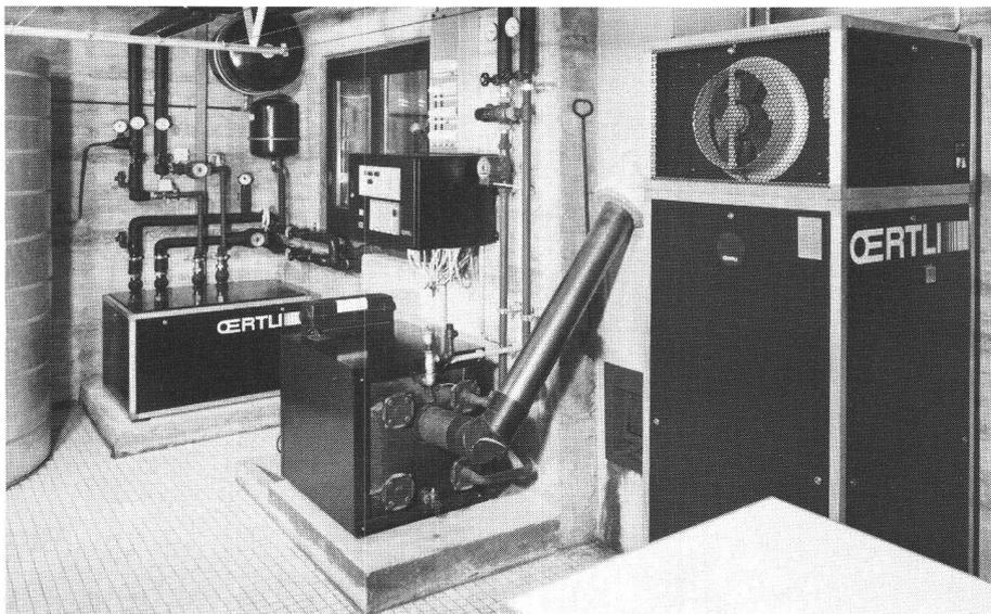
Le chauffage bivalent Oertli Casa-Block avec pompe à chaleur, accumulateur intermédiaire, dispositif de commande pour tout le système de chauffage, petite chaudière pour fonctionnement à mazout ou gaz. Au premier plan, le chauffe-eau à pompe à chaleur pour l'eau sanitaire.
