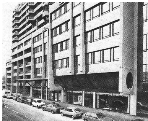
Les nouveaux locaux situés au quai du Seujet 28-30, en bordure du Rhône.
