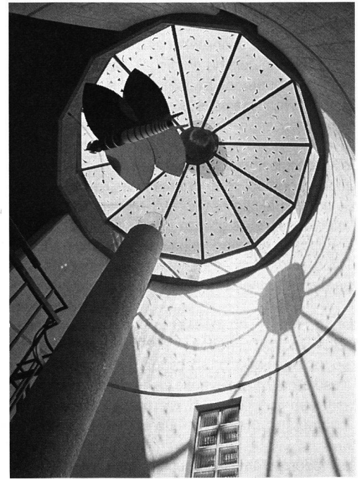
Verrière de l'escalier, intervention de Gérald Poussin.
