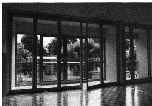
Double façade (serre), 1 er étage.
