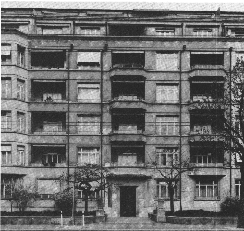
Façade sur l'avenue de Rumine.
