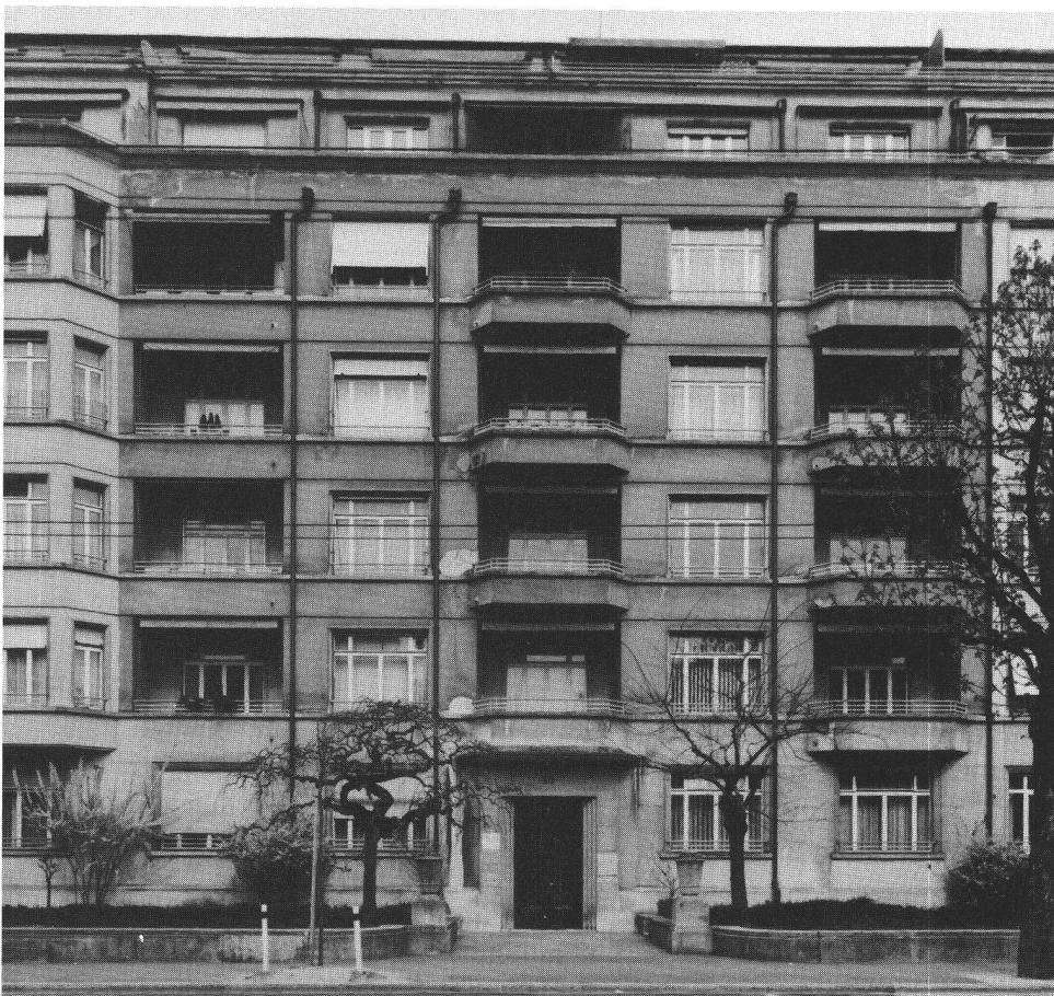
Façade sur l'avenue de Rumine.
