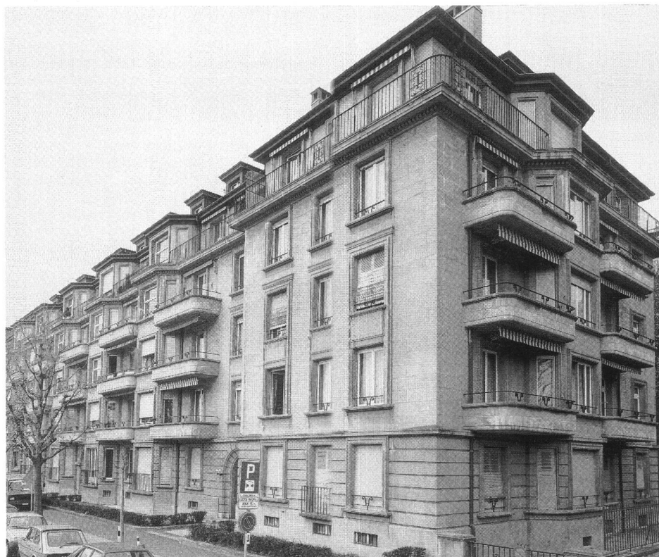
Vue de l'angle entre la façade sud et la façade est.
