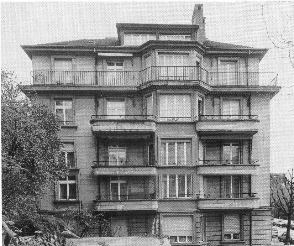
Vue de la façade ouest.
