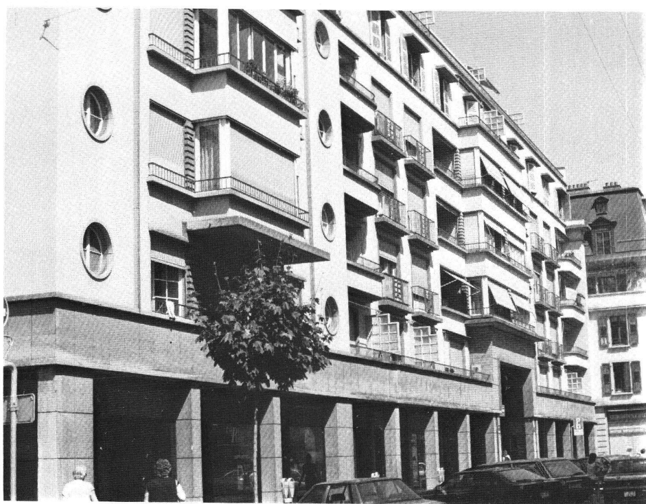
Vue de la façade sud
