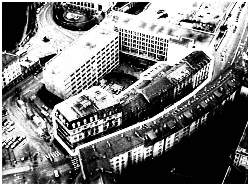
L'opération Riponne-Tunnel suppose la suppression de 85 logements vétustes, exposés au bruit du trafic de la rue du Tunnel.
