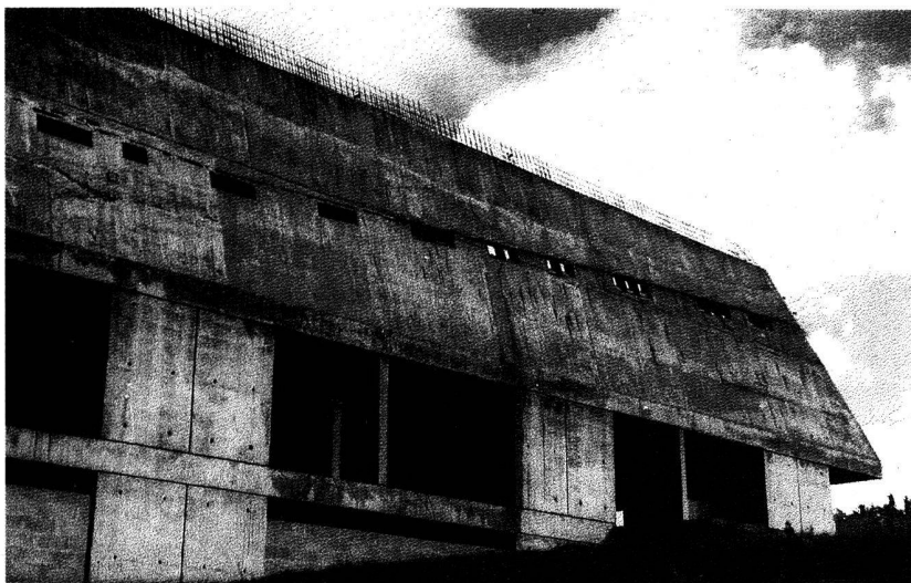
L'église Saint-Pierre... état du chantier
