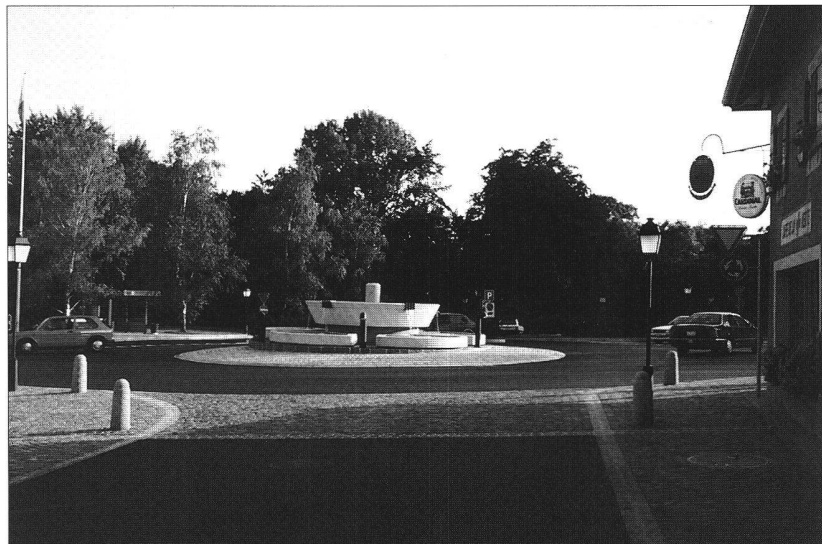
Les normes réinterprétées dans un langage urbain : trottoir et chaussée à niveau, revêtements particuliers
