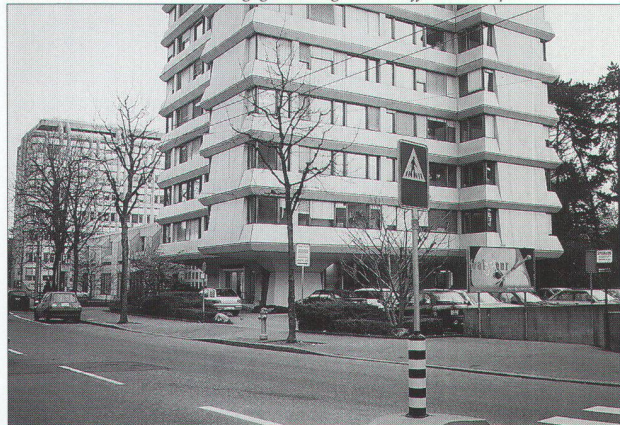
immeuble tour avec bureaux, dégagé de l'alignement, offrant un espace d'accès
