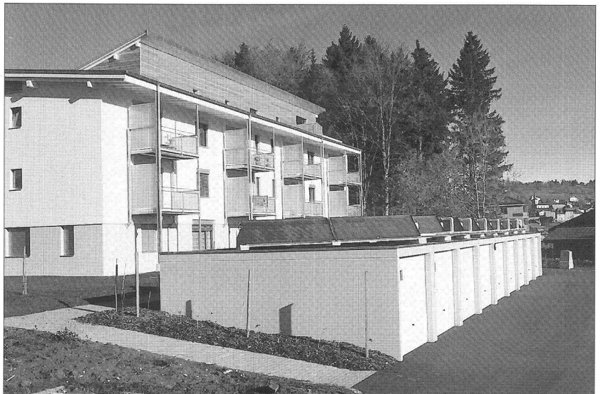
Ci-dessous : les accès et garages, avec les panneaux solaires
